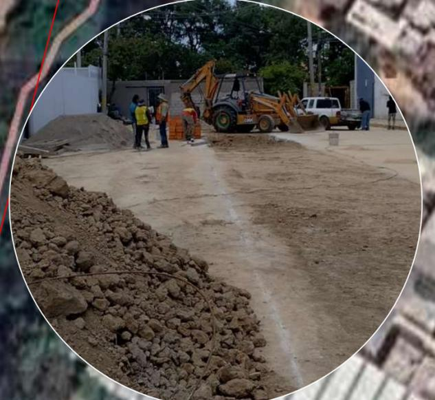
TRAYECTORIA DEL TUBO QUE CONECTARA DESDE EL REGISTRO DE LAS CUNETAS HASTA DESCARGAR EN LA BARRANCA.
